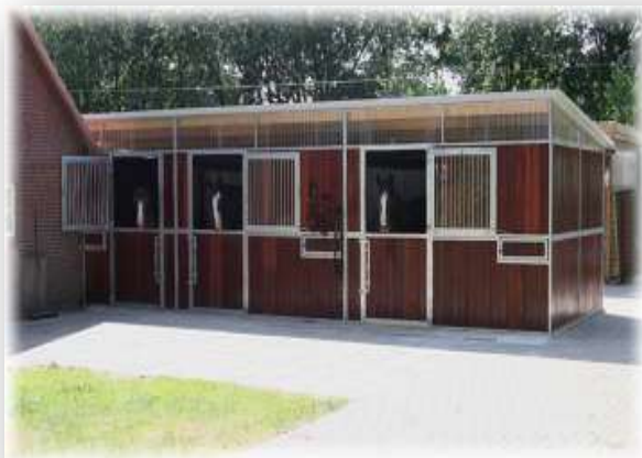
Außenboxen am Wohnhaus
