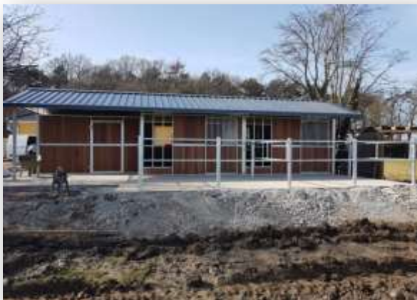
3er-Außenboxenstall mit Sattelkammer
