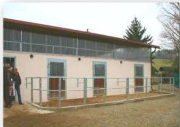
Außenboxen Mauerwerk mit Paddock
