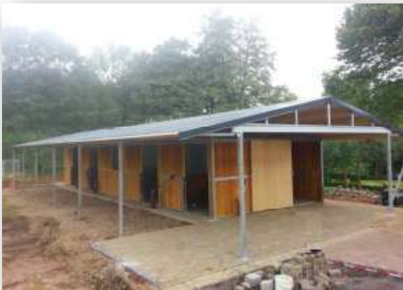
Außenboxenstall mit einseitiger Stallgasse
